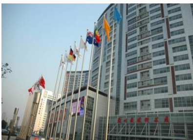
苏州国际科技园
